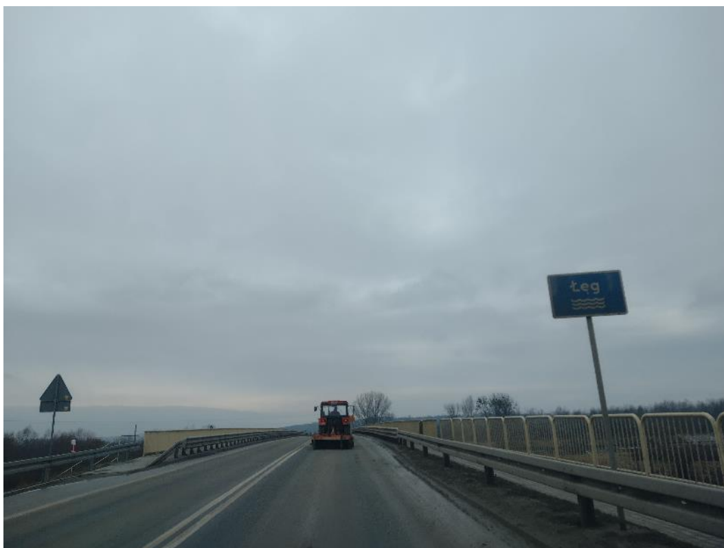
Fot. 23. Widok na drogę krajową nr 77 – oczyszczanie drogi na odcinku wyjazdu i wjazdu na teren budowy, styczeń 2022 r.
