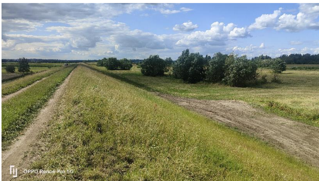
Fot. 42. Widok na zakończone prace w rejonie wału prawego, lipiec 2023 r.
