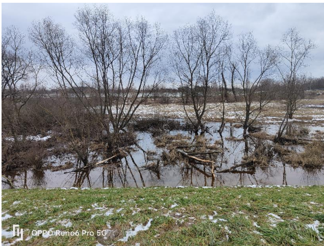
Fot. 21. Widok na lewy wał w km ok. 4+900 – siedlisko bobra europejskiego Castor fiber , styczeń 2022 r.
