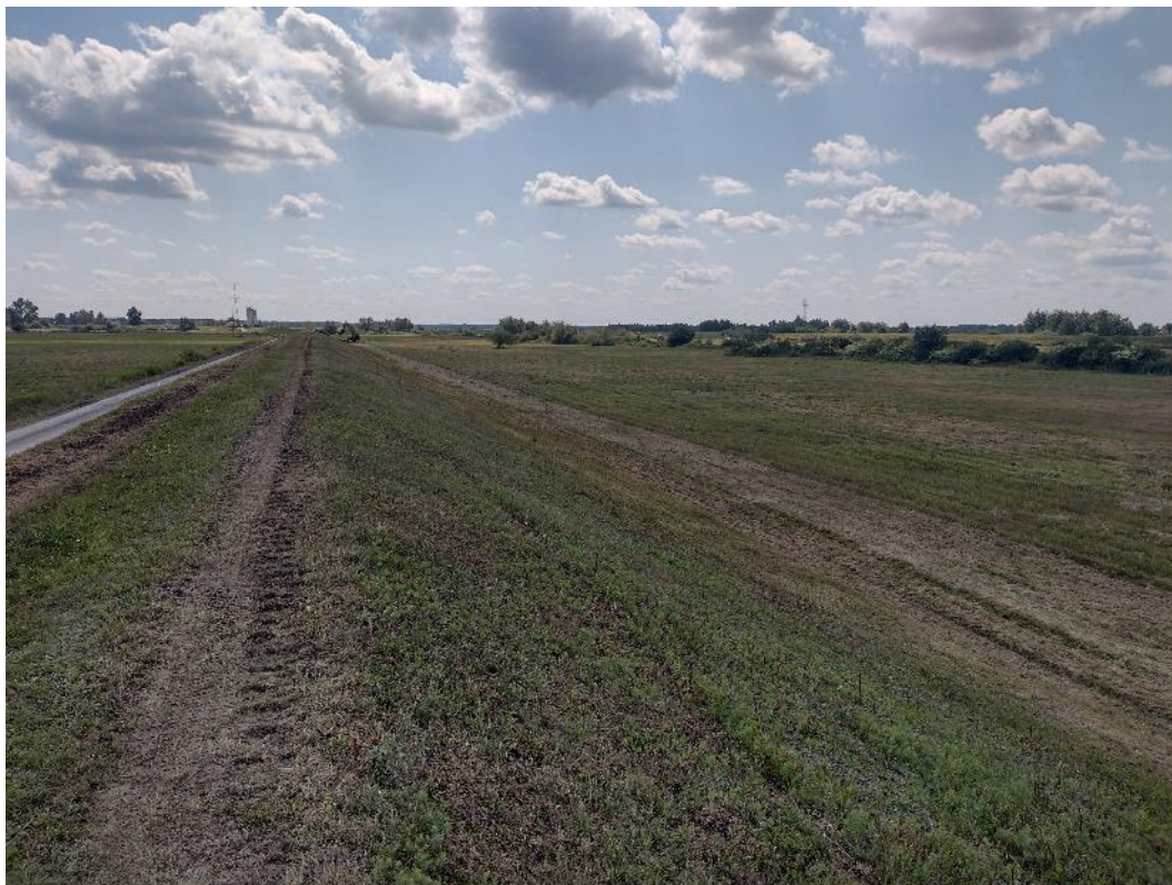
Fot. 1. Widok na prawy wał w km ok. 2+750 – stan przed rozpoczęciem robót, sierpień 2021 r.
