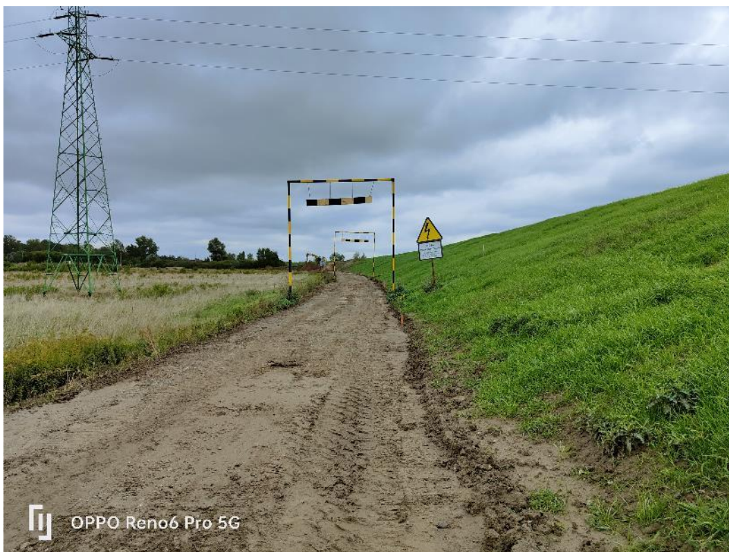
Fot. 32. Widok na prawy wał w km ok. 4+100 – bramownice - strefy zabezpieczenia pod czynną linią elektroenergetyczną, wrzesień 2022 r.
