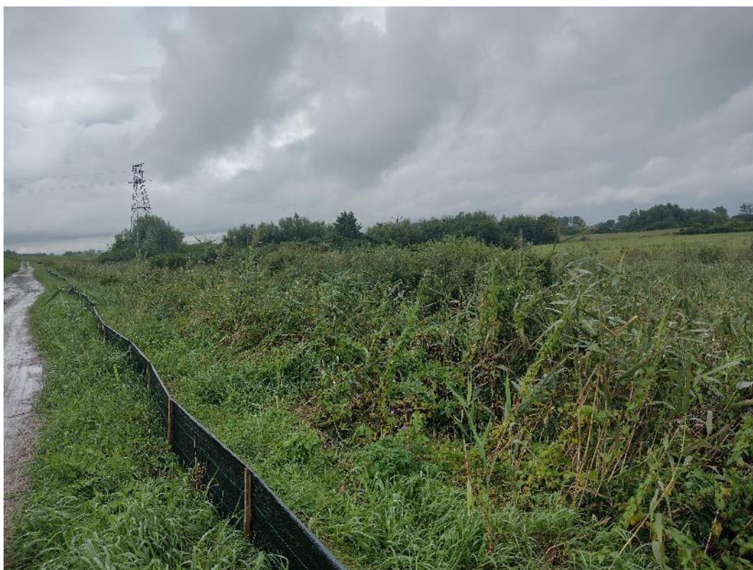
Fot. 10. Widok na prawy wał w km ok. 1+120 – prawidłowo wykonane wygradzenia herpetologiczne, sierpień 2021 r.
