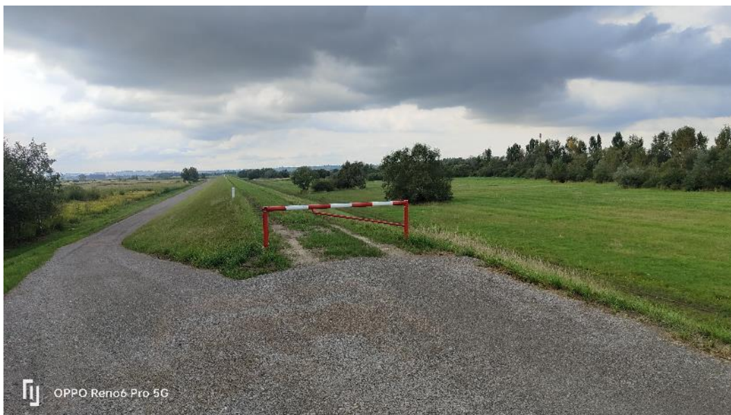
Fot. 46. Widok na zakończone prace w rejonie wału lewego, w tym wykonane bariery, sierpień 2023 r.
