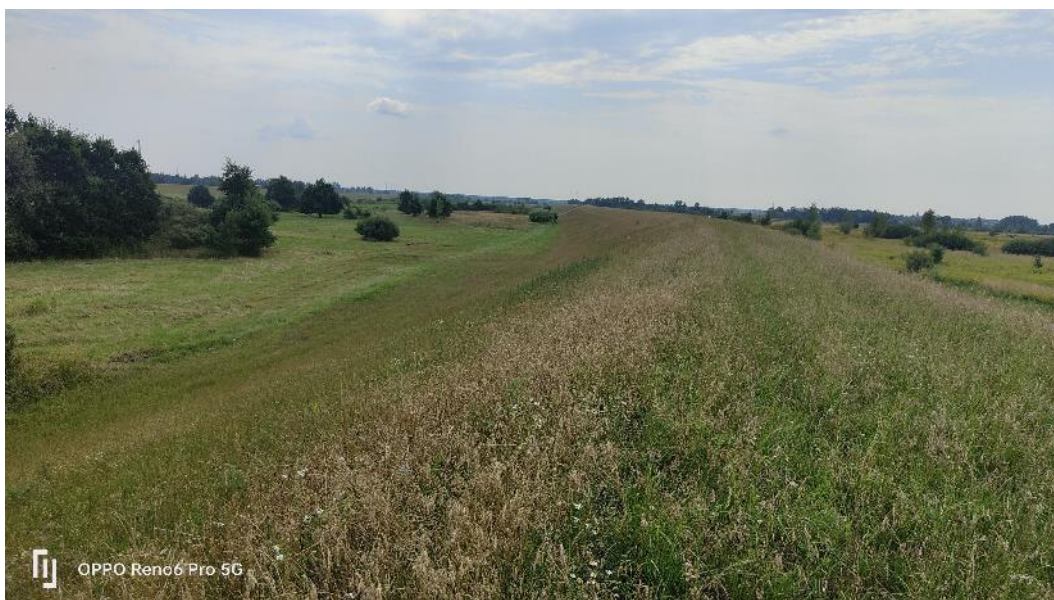
Fot. 45. Widok na zakończone prace w rejonie wału prawego, sierpień 2023 r.
