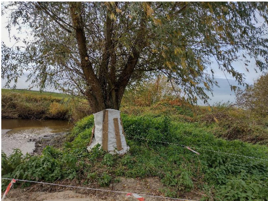
Fot. 15. Widok na prawy wał w km ok. 3+850 – wygradzenie drzew pozostawionych poza wycinką oraz oznakowanie granic terenu robót, październik 2021 r.
