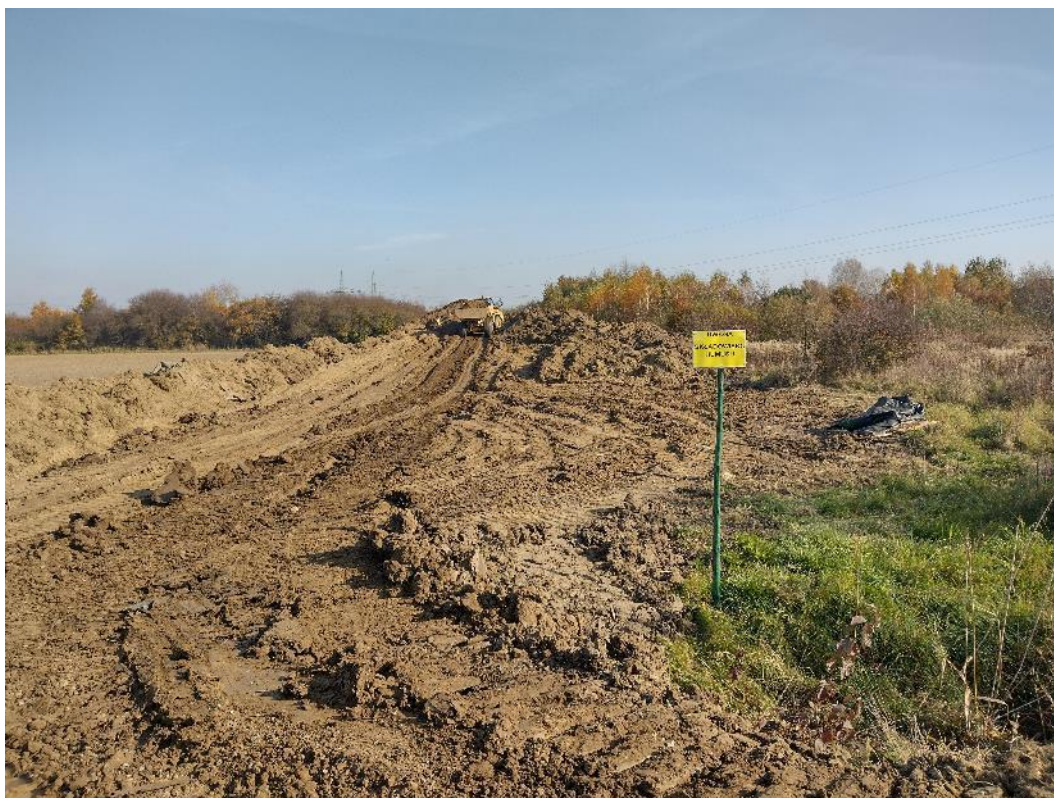
Fot. 8. Widok na prawy wał w km ok. 1+350 – oznakowanie strefy składowania humusu, październik 2021 r.
