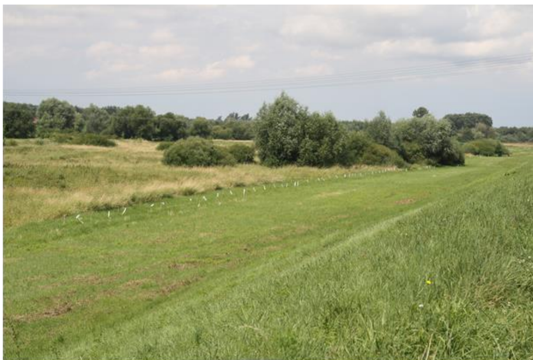
Fot. 13. Widok na prawy wał w km ok. 3+300 – oznakowanie linii rozgraniczających teren budowy, wrzesień 2021 r.
