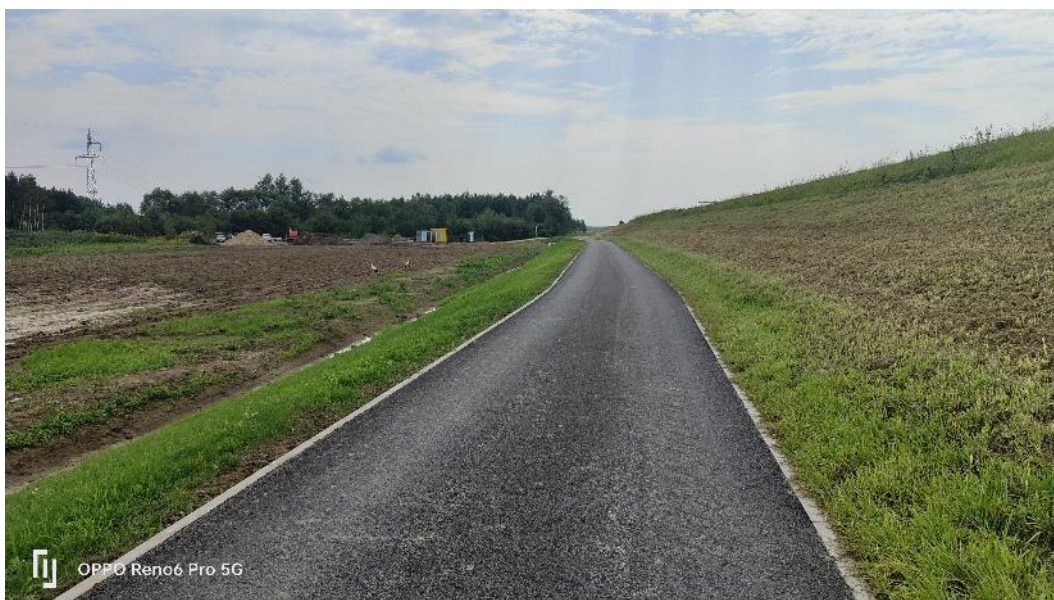
Fot. 47. Widok na zakończone prace w rejonie wału prawego, w tym wykonane koszenie traw, sierpień 2023 r.
