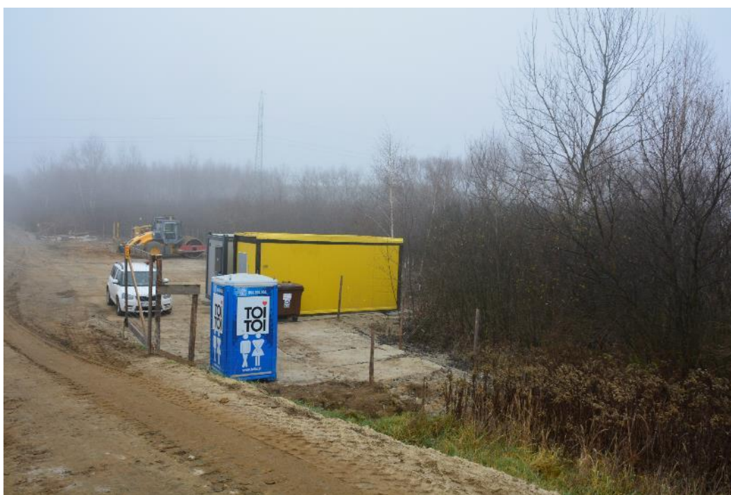
Fot. 4. Widok na prawy wał w km ok. 2+400 – właściwe przygotowanie zaplecza budowy, listopad 2021 r.
