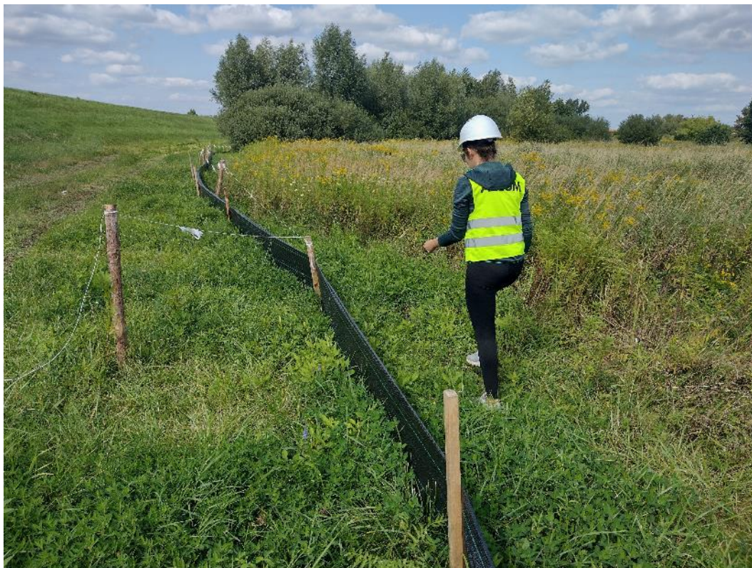
Fot. 9. Widok na lewy wał w km ok. 1+700 – kontrola stanu wykonanych tymczasowych wygradzeń herpetologicznych, sierpień 2021 r.
