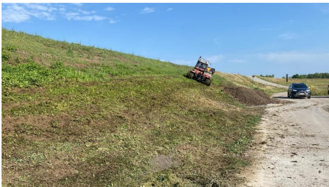
Fot. 41. Widok na prace koszenia wałów (wał prawy), lipiec 2023 r.
