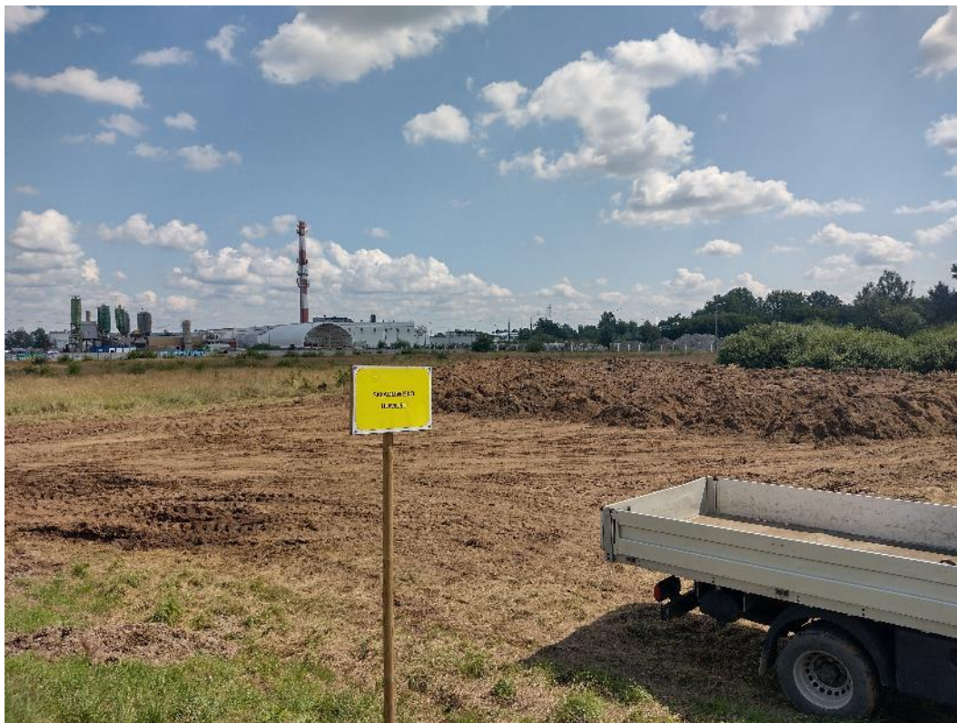
Fot. 7. Widok na prawy wał w km ok. 3+400 – przygotowana i oznakowana strefa składowania humusu, sierpień 2021 r.
