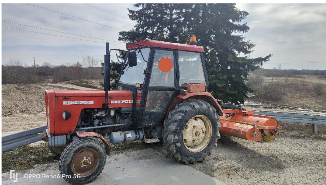
Fot. 24. Widok na okolice przecięcia wału prawnego z drogą krajową nr 77 – utrzymywanie czystości dróg dojazdowych do terenu budowy, marzec 2023 r.
