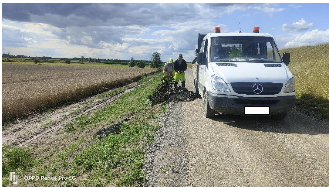
Fot. 43. Widok na prace porządkowe, wał lewy, lipiec 2023 r.
