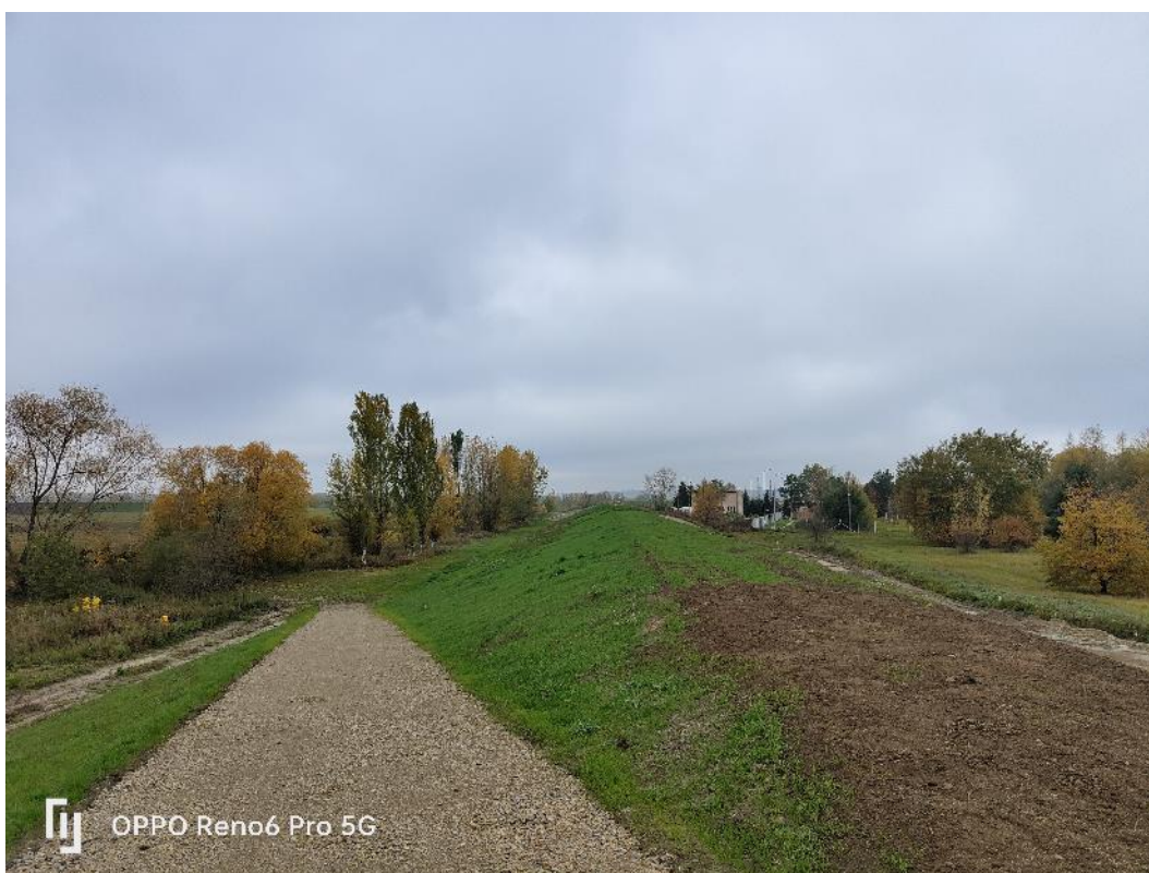
Fot. 30. Widok na prawy wał w km ok. 3+900 – widok na wykonane prace rozbudowy wałów i rekultywacji, październik 2022 r.
