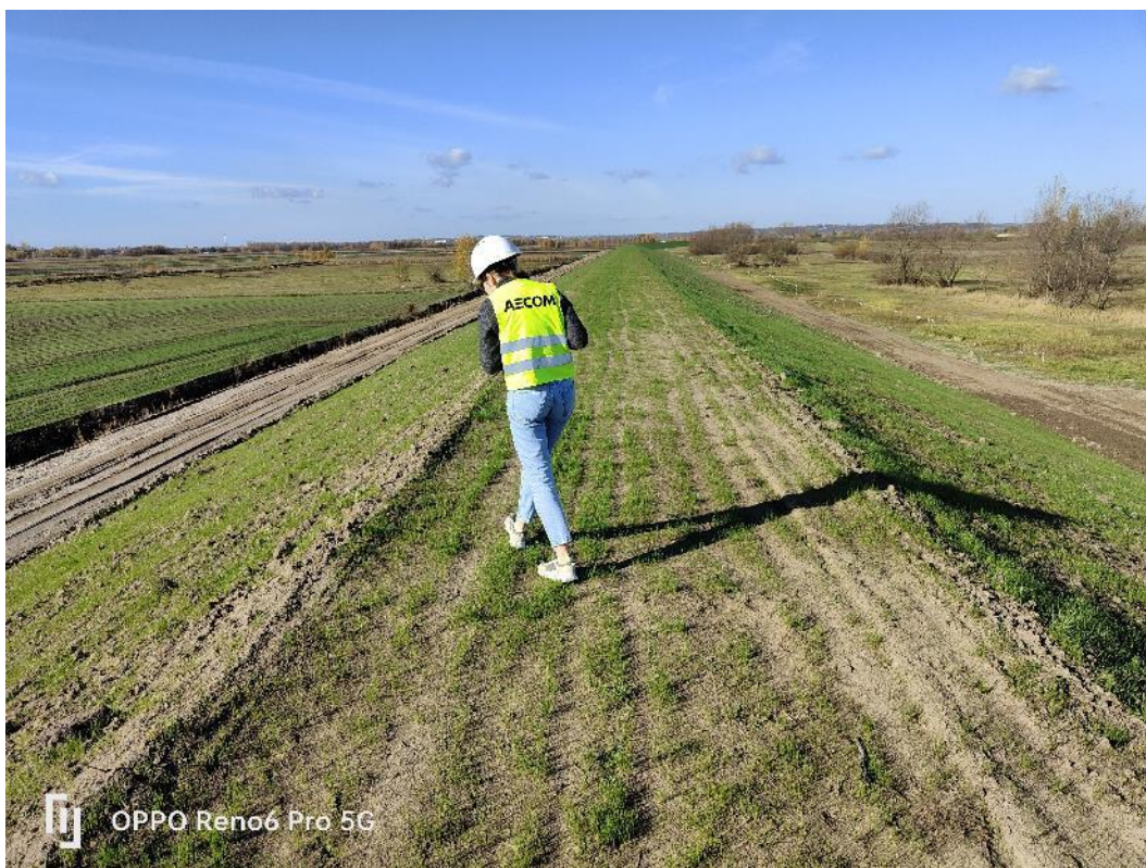
Fot. 29. Widok na lewy wał w km ok. 3+900 – kontrola obsiewu traw na odcinku zakończonych prac rozbudowy wału i rekultywacji, listopad 2022 r.
