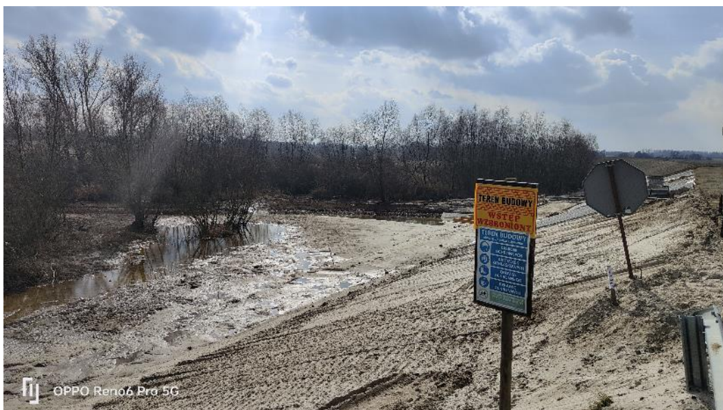
Fot. 33. Widok na lewy wał w km ok. 1+200 – prawidłowe oznakowanie terenu budowy, marzec 2023 r.
