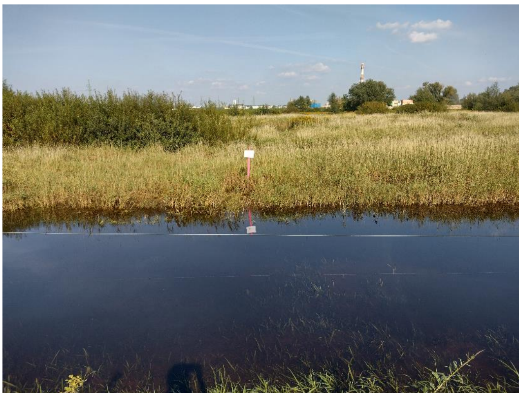
Fot. 12. Widok na lewy wał w km ok. 3+000 – oznakowanie cennych siedlisk flory i fauny, wrzesień 2021 r.
