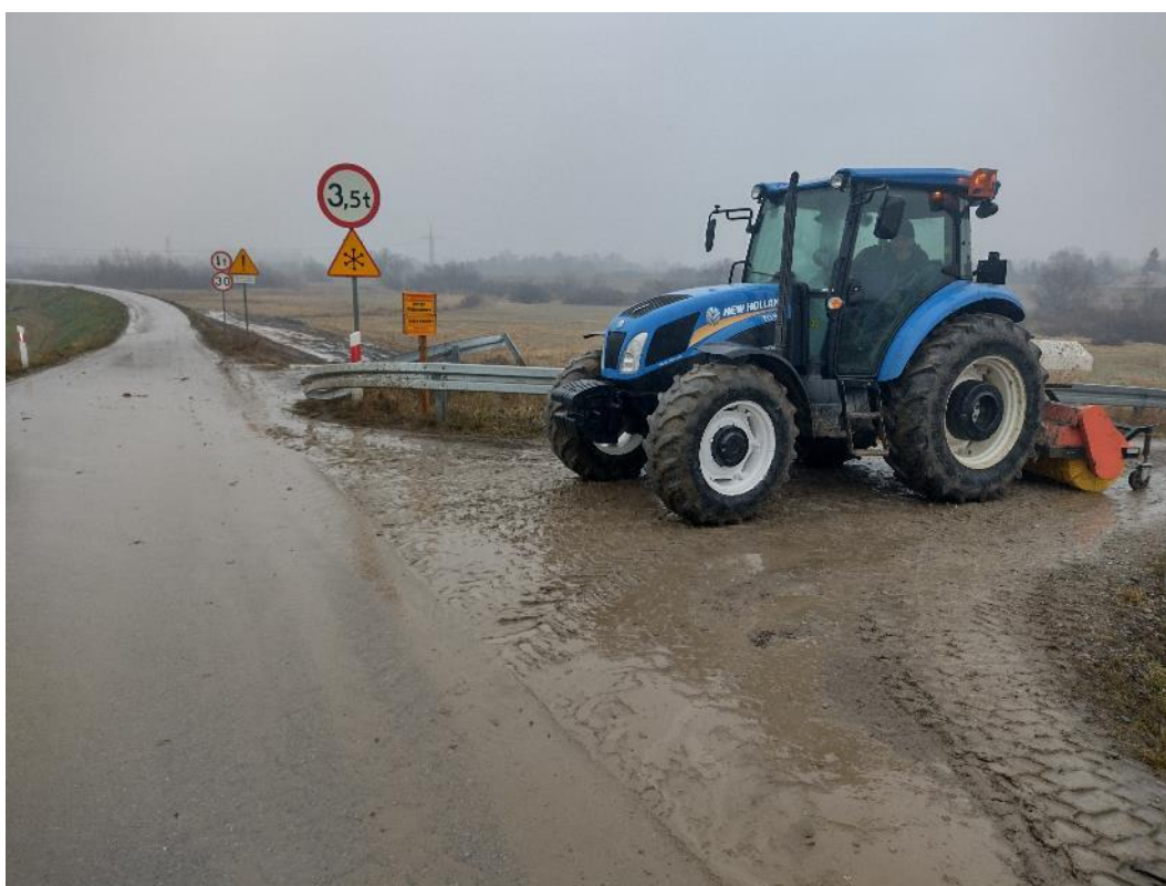
Fot. 22. Widok na lewy wał w km ok. 1+100 – utrzymywanie czystości dróg dojazdowych do terenu budowy, grudzień 2021 r.
