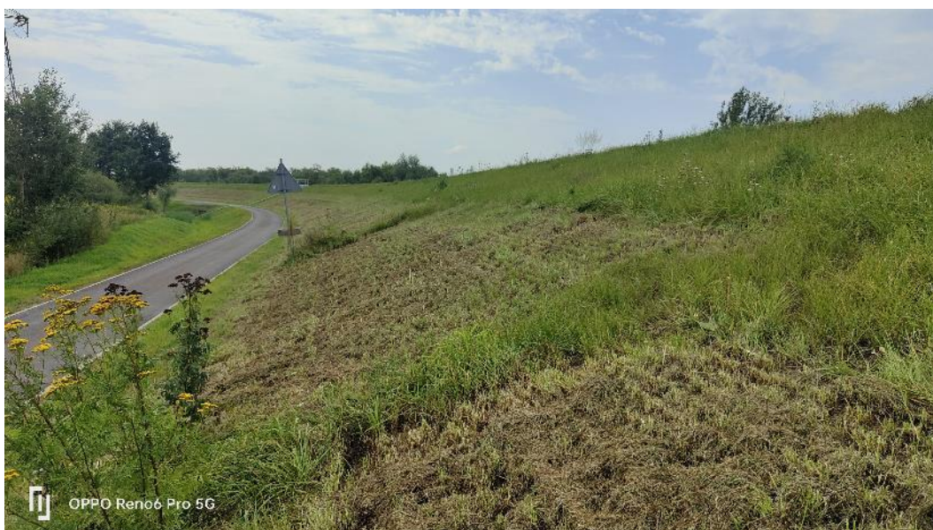
Fot. 44. Widok na zakończone prace w rejonie wału prawego, w tym wykonane prace pielęgnacji powierzchni trawiastych na wale, sierpień 2023 r.
