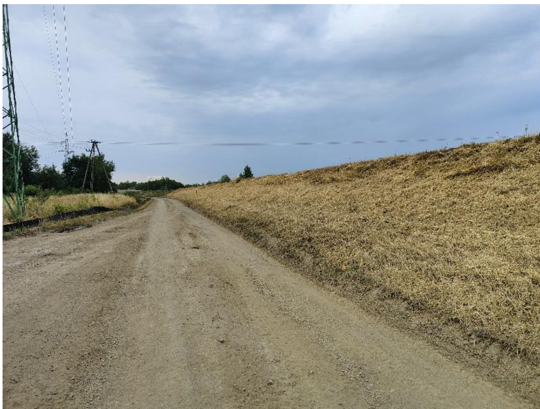
Fot. 26. Widok na prawy wał w km ok. 2+000 – wykaszanie traw w rejonie wałów, lipiec 2022 r.
