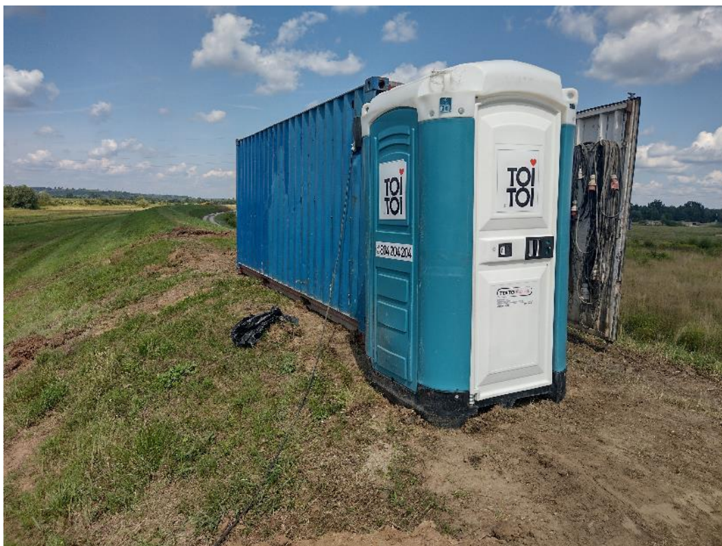
Fot. 2. Widok na prawy wał w km ok. 3+370 - organizacja strefy zaplecza budowy wraz z dostępnością urządzeń sanitarnych, sierpień 2021 r.
