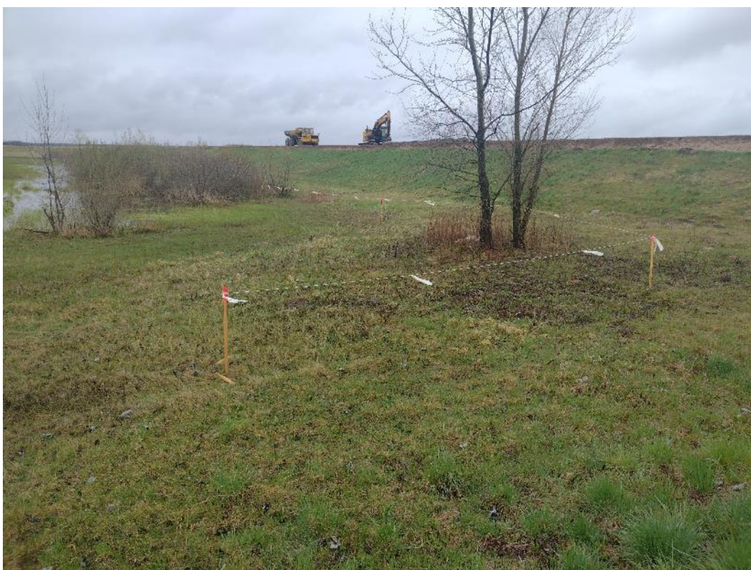
Fot. 14. Widok na lewy wał w km ok. 3+050 – oznakowanie granic terenu robót, kwiecień 2022 r.
