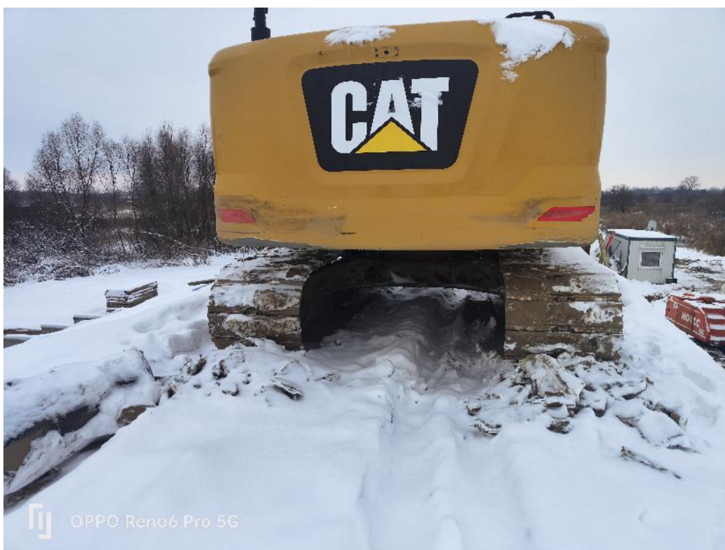
Fot. 36. Widok na lewy wał w km ok. 1+200 – kontrola pojazdów budowy – brak wycieków ropopochodnych, grudzień 2022 r.
