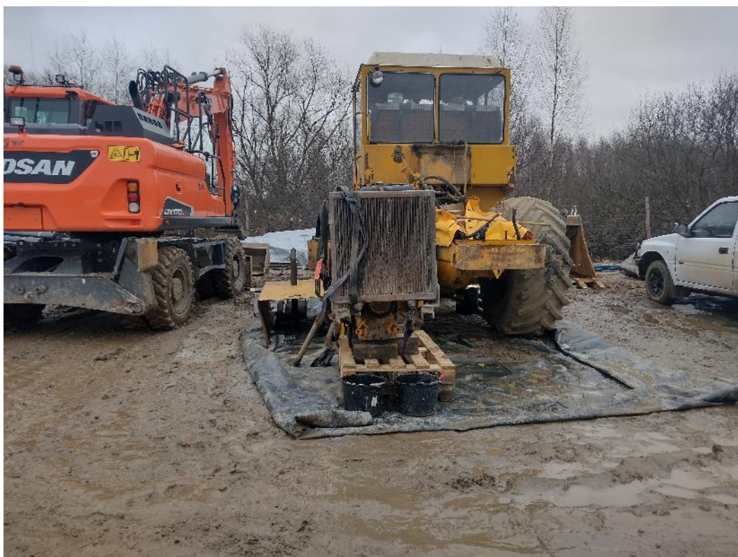
Fot. 6. Widok na prawy wał w km ok. 2+400 – zaplecze budowy – uszczelnienie podłoża pod serwisowanymi maszynami, styczeń 2022 r.
