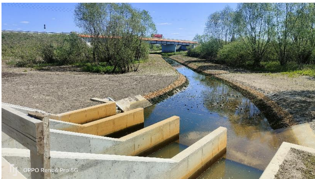
Fot. 37. Widok przepompowni w rejonie wału lewego – widok na wykonane prace, maj 2023 r.
