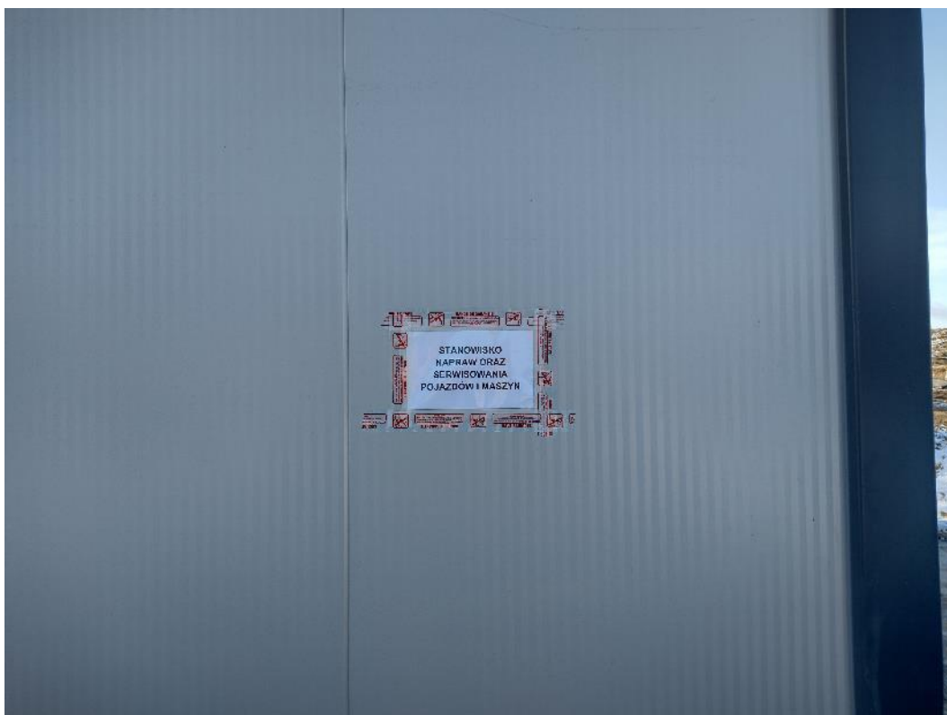
Fot. 5. Widok na prawy wał w km ok. 2+400 – zaplecze budowy – oznakowanie strefy napraw i serwisowania pojazdów oraz maszyn, styczeń 2022 r.
