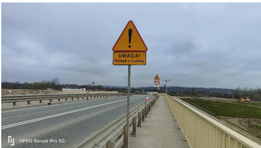
Fot. 34. Widok na okolice przecięcia wału lewego z drogą krajową nr 77 – oznakowanie wyjazdu z terenu budowy, marzec 2023 r.
