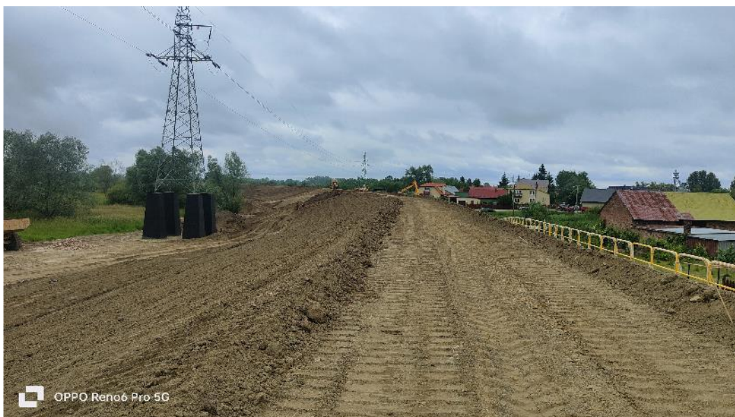
Fot. 39. Widok na wał prawy w km ok. 1+700 – wykonane prace rekultywacji terenu, przygotowanie odcinka do obsiewu mieszankami traw, czerwiec 2023 r.
