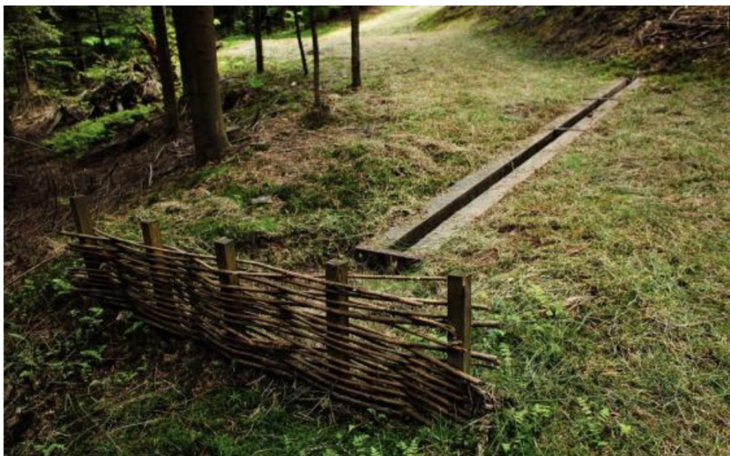
Wodospust i rozpraszacz spowalniający spływ wody i zatrzymujący osady na drodze leśnej. Źródło: www.ckps.lasy.gov.pl
